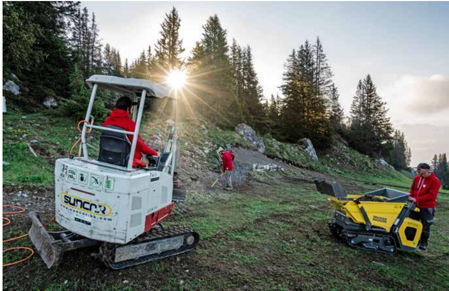
Für den Bau des Nagens-Trails in Laax (Bild links) nutzte das Team ausschliesslich elektrische Energie. Auch bei den Pumptracks (Bild rechts) setzt Velosolutions möglichst auf E-Energie. Allerdings gibt es aktuell noch keinen akkubetriebenen Bagger in angemessener Grösse.
